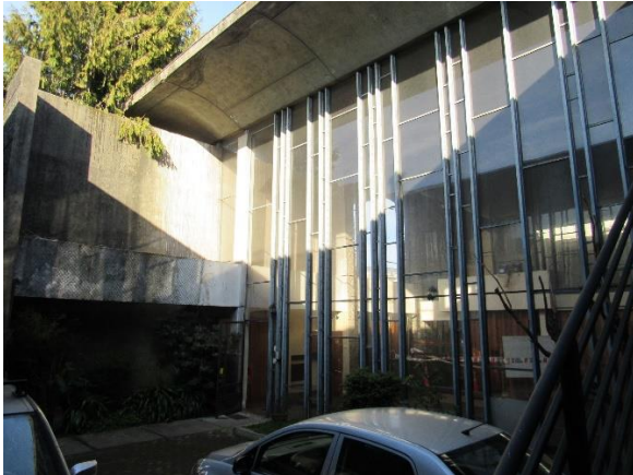
Estacionamiento con acceso inclusivo
